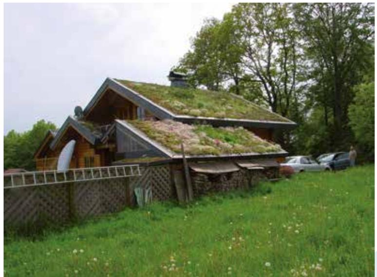
Beispiel: Schrägdach mit Dachbegrünung [Bild: DDV]
