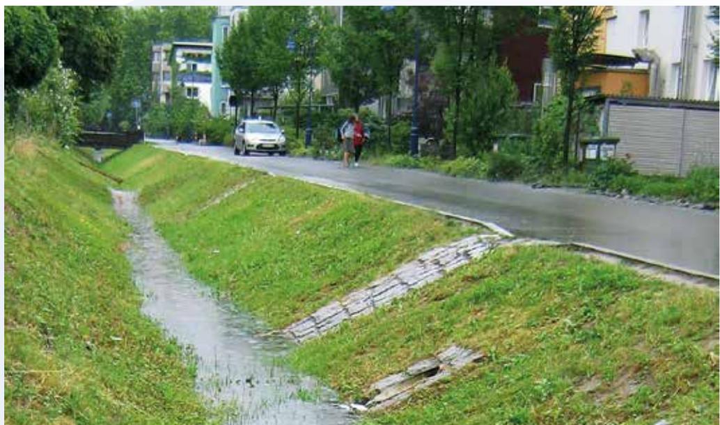
Semizentrale Mulden-Rigole zur Versickerung des Niederschlagswassers von Privatgrundstücken und öffentlichen Straßen, Freiburg, Vauban [Bild: Jackisch]
