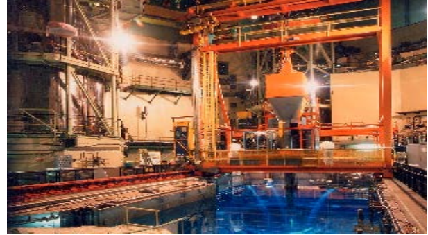
Innenansicht Reaktorgebäude KKW Fessenheim
