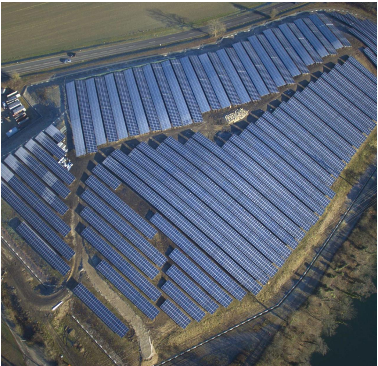
Solarpark Herten, Quelle: EWS Schönau
