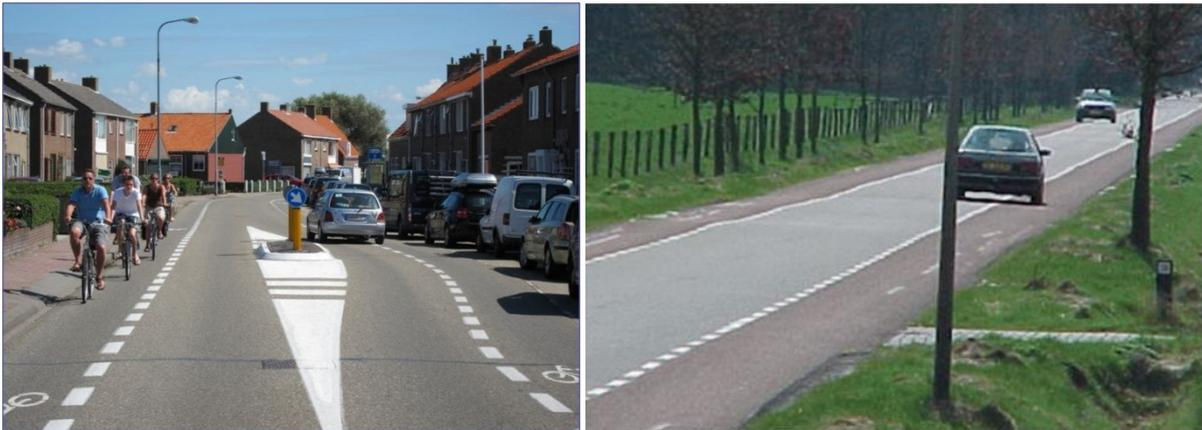
Abb. 6: Schutzstreifen (Suggestiestrook) in den Niederlanden werden auf schmalen Fahrbahnen unter 7,00 m sowohl innerorts als auch außerorts markiert. Eine Mindestkernfahrbahnbreite ist nicht vorgeschrieben.
