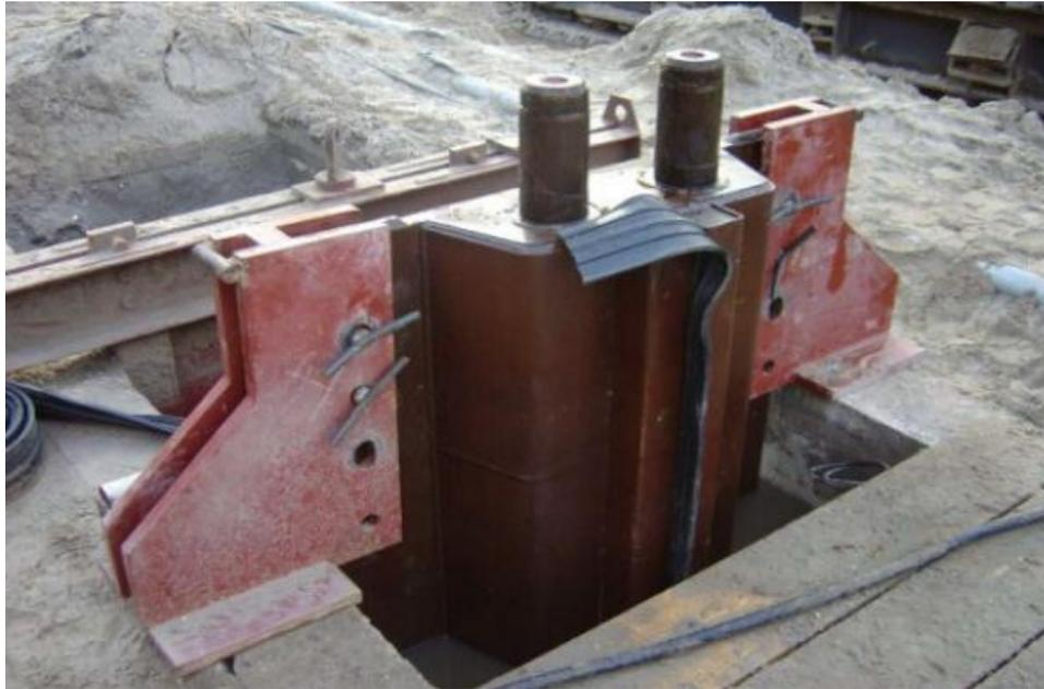
**Abbildung 4-9:** *Abschalelement mit eingesetztem Fugenband*
