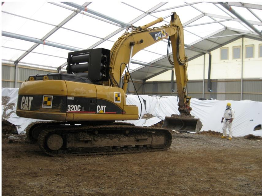
**Abbildung 7:** Hallenkonstruktion mit umgebungsluftunabhängigem Bagger und Überwachung durch Bauaufsicht
